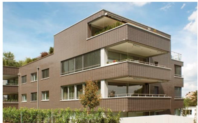
Mehrfamilienhaus, Kilchberg, Schweiz / Architekt: Horizon Architektur + Bau AG, Zürich, Schweiz · Apartment building, Kilchberg, Switzerland / Architect: Horizon Architektur + Bau AG, Zurich, Switzerland
