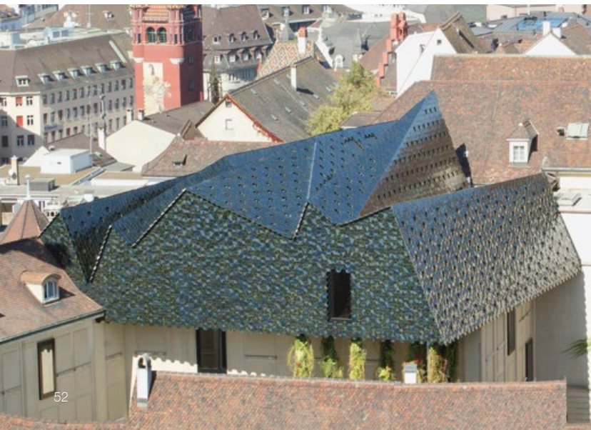
Museum der Kulturen, Basel, Schweiz / Architekten: Herzog & de Meuron Museum of Cultures, Basle, Switzerland / Architects: Herzog & de Meuron
