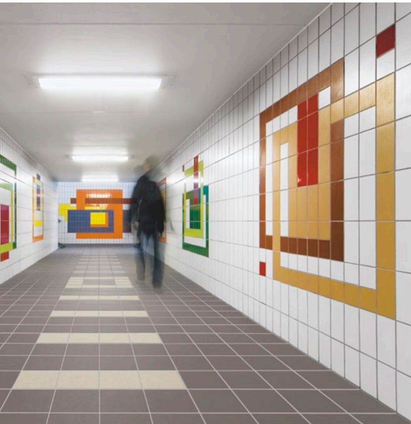
Bahnunterführung, Mögglingen, Deutschland Railway underpass, Mögglingen, Germany
